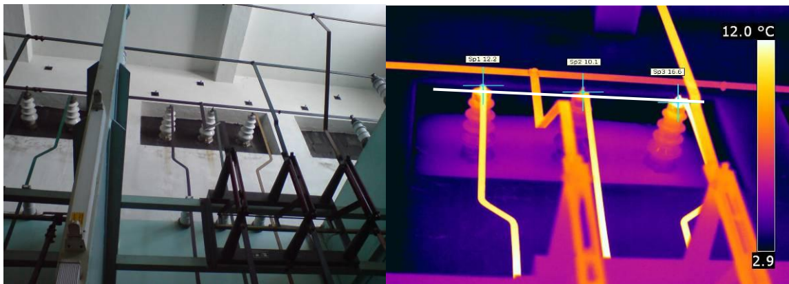
Slika 3. a) Fotografaska i b) termografska slika unutrašnjih delova provodnih izolatora na 35 [kV] strani
